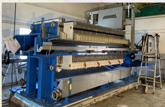
Filter Press Installation at Sludge Dewatering House in Progress 污泥脫水大樓壓濾機安裝工程進行中
