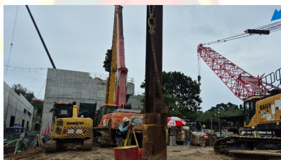
Piling works for Sludge Centrifuge House in Progress 污泥離心機大樓的地基工程正在進行中
